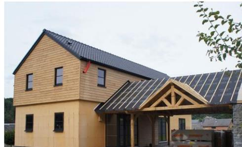
Construction en ossature bois « très basse énergie ». Le bardage (150 m<sup>2</sup>), le carport, ainsi que la charpente traditionnelle et le parquet (200 m<sup>2</sup>), sont en chêne indigène provenant de la scierie Hontoir, distante d'une quinzaine de kilomètres.
